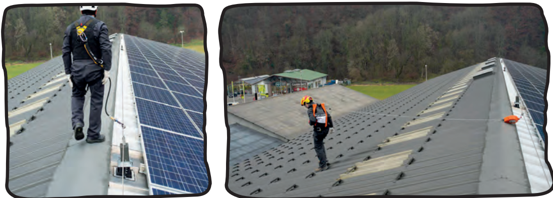
Ligne de vie au faitage
